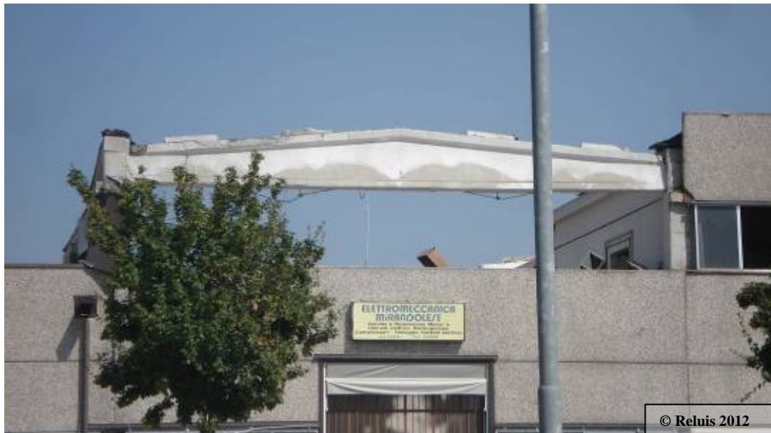
Figura 1 - Vista di parte di un complesso edilizio di edifici prefabbricati: collasso della copertura in tegoli prefabbricati e dei pannelli di tamponatura orizzontali
