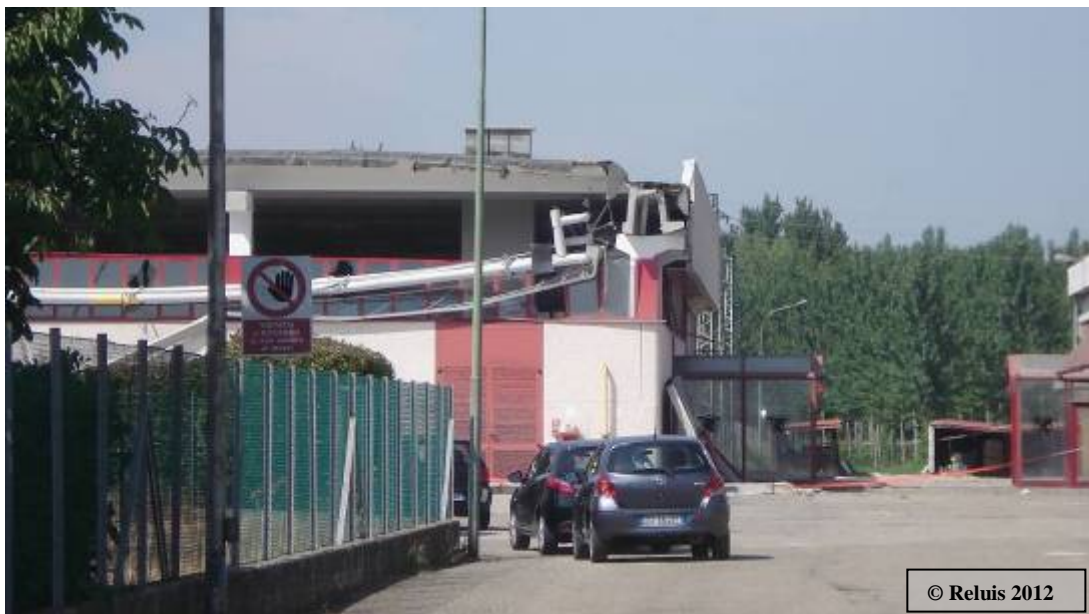
Figura 4 – Collasso di pannelli di tamponatura orizzontali
