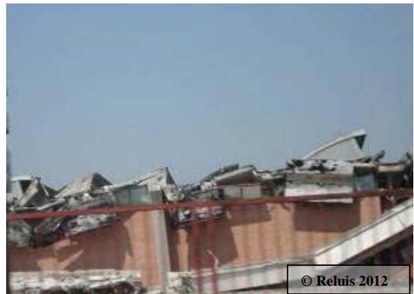
Figura 1 - Vista di parte di un complesso edilizio di edifici prefabbricati: collasso della copertura in tegoli prefabbricati e dei pannelli di tamponatura orizzontali
