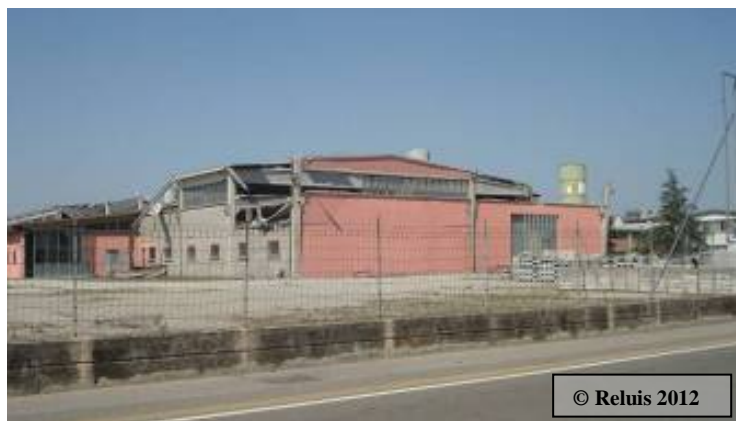
Figura 9 – Collasso e collasso incipiente di pannelli orizzontali di tamponatura
