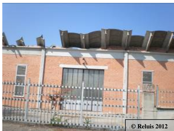
Figura 16 – Collasso copertura con tegoli ad “Y” distanziati
