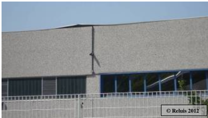
Figura 9 – Collasso e collasso incipiente di pannelli orizzontali di tamponatura
