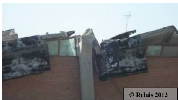
Figura 2 – Collasso copertura con shed
