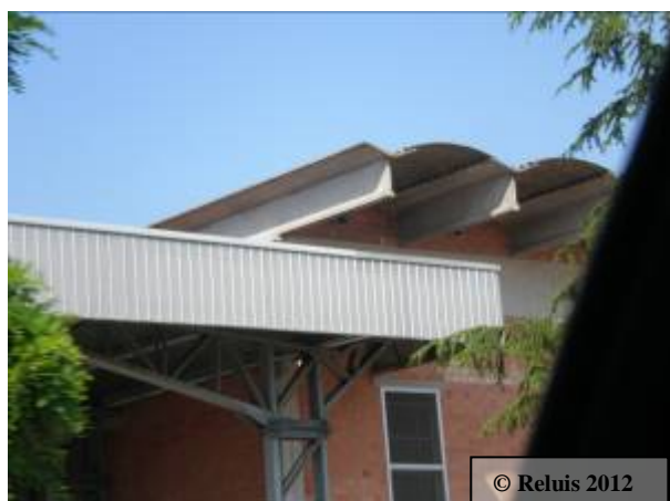
Figura 16 – Collasso copertura con tegoli ad “Y” distanziati
