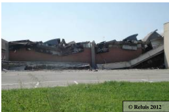
Figura 1 - Vista di parte di un complesso edilizio di edifici prefabbricati: collasso della copertura in tegoli prefabbricati e dei pannelli di tamponatura orizzontali
