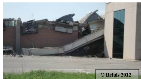
Figura 2 – Collasso copertura con shed
