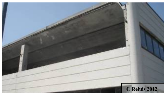
Figura 4 – Collasso di pannelli di tamponatura orizzontali
